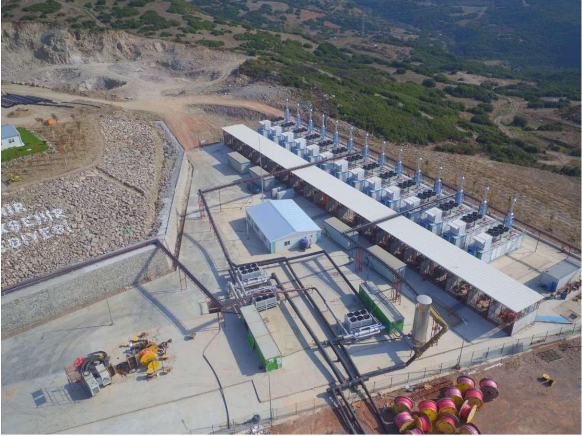
Şekil 5 Düzenli Depolama Alanında Depo Gazından Enerji Üretimi
